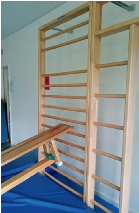
Abb. 44: Fallhöhe (von ganz oben) auf Bank, erhöhte Verletzungsgefahr.
