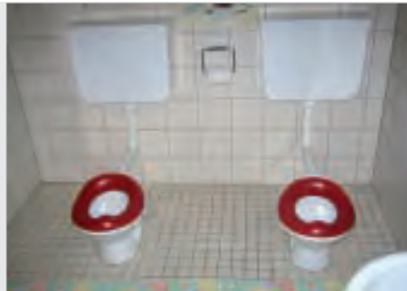
Links: Toilette mit Elefantenfüßen Rechts: Zwei Mini-Toiletten
